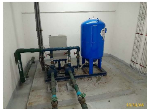
ระบบสูบน้ำใช้ชั้นหลังคา
