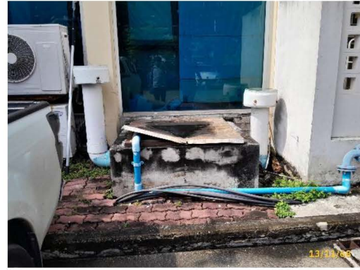
ฝาท่อถังเก็บน้ำใช้แต่ละอาคาร
