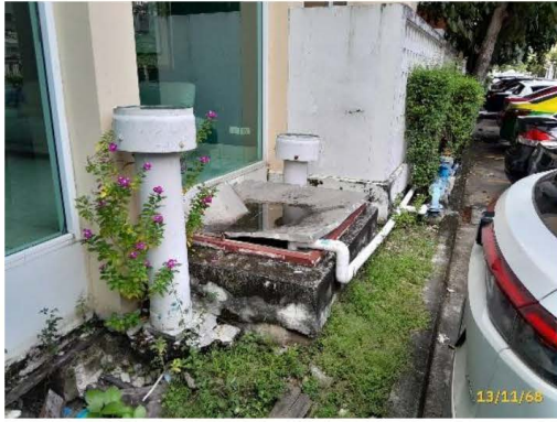
ฝาท่อถังเก็บน้ำใช้แต่ละอาคาร
