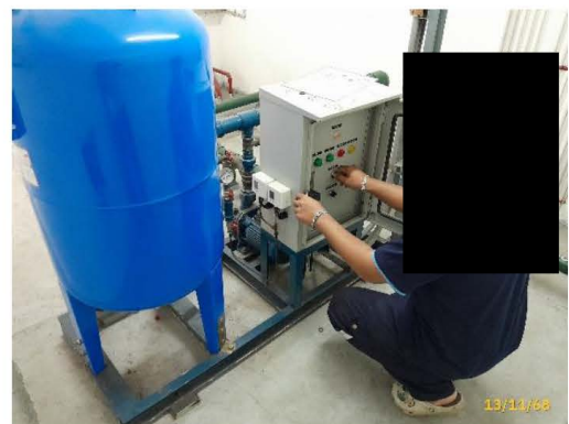
การตรวจสอบการทำงานของระบบประปา
